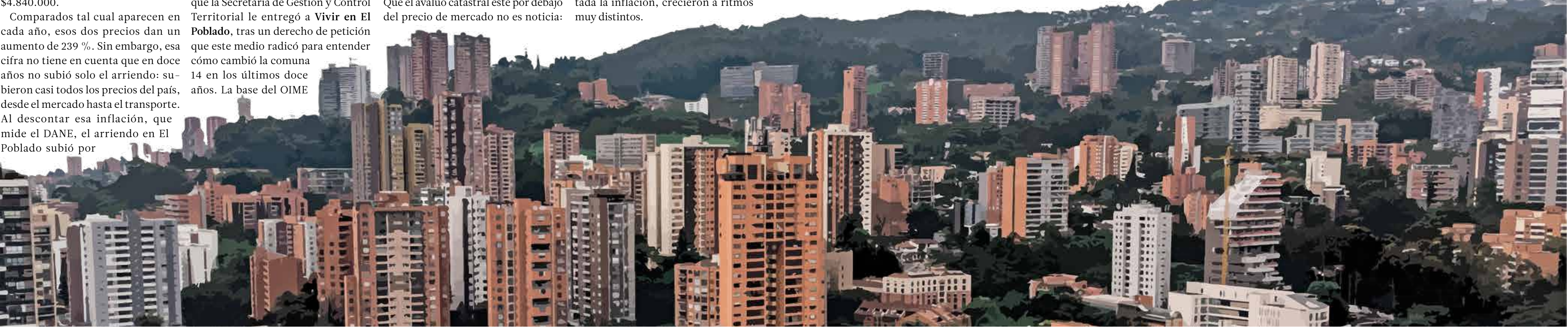
El crecimiento inmobiliario de El Poblado ha sumado más predios y construcciones en altura sobre una superficie de suelo que prácticamente no ha cambiado.
