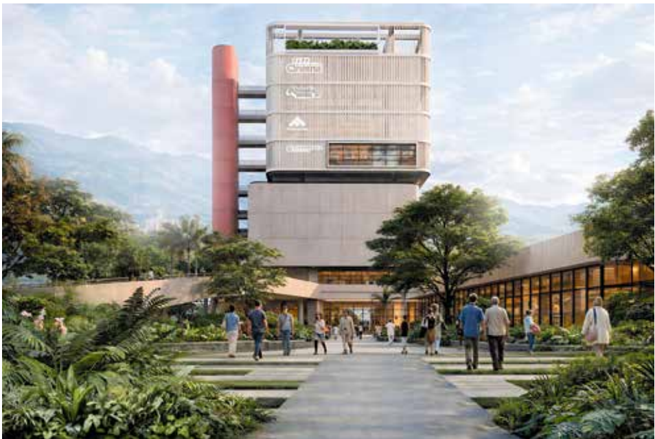
El complejo Recreo Cultural Ciudad del Río consta de un edificio central de 11 niveles, más sótano; con rampas peatonales de acceso, zonas verdes y amoblamiento urbano.
