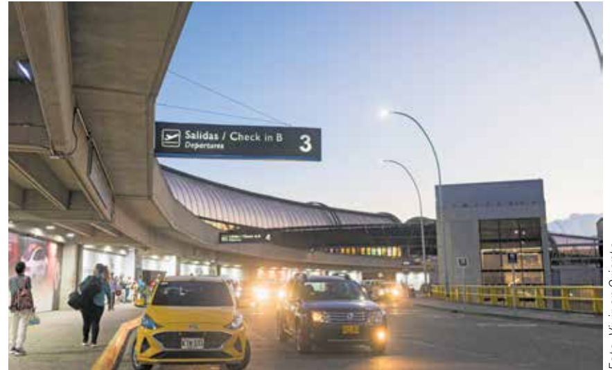
La Aeronáutica Civil precisó que la ejecución de las obras dependerá de las autorizaciones y requisitos legales correspondientes en cada etapa de la intervención.
