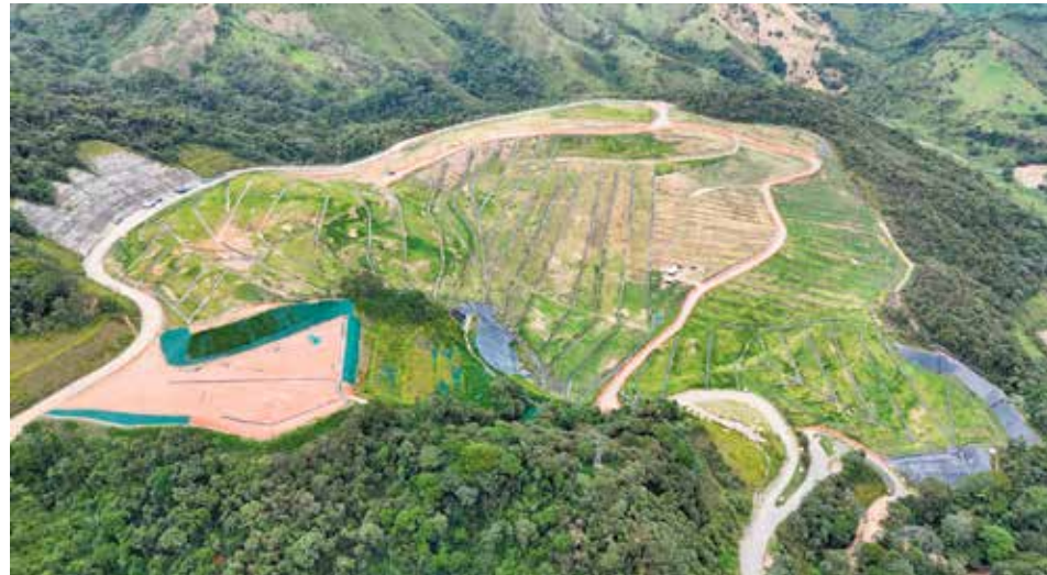
Biogás en el relleno sanitario La Pradera.
