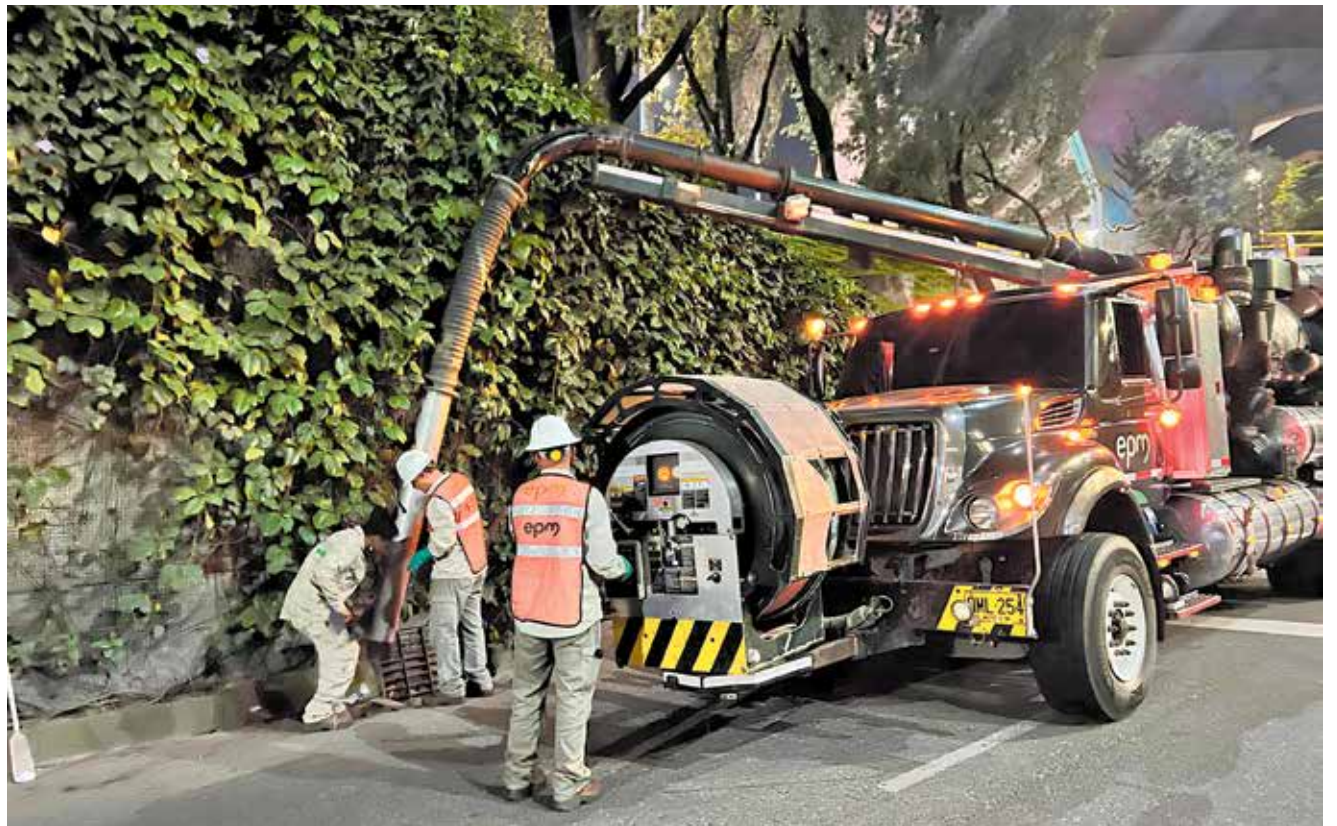
Los equipos de EPM realizan mantenimiento preventivo y correctivo de la red de alcantarillado para garantizar su adecuado funcionamiento, sin embargo, el cuidado también comienza con los hábitos de cada hogar.
