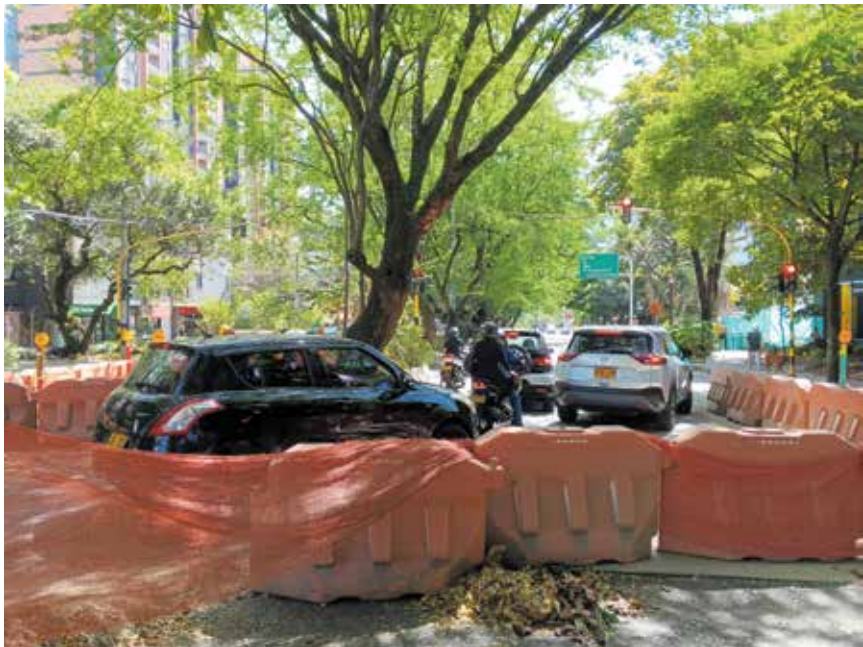
Mientras se habilita la calzada oriental, en la occidental hay paso por un carril, entre la bomba de gasolina y la serviteca que allí operan de tiempo atrás y que seguirán ahí.
