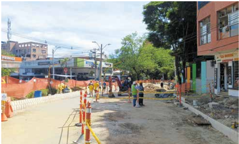
Las obras empezaron en febrero, con un plazo de ejecución de siete meses. Aún falta culminar la gestión predial de algunos antejardines, sobre todo en el costado occidental del llamado tramo 2C.
