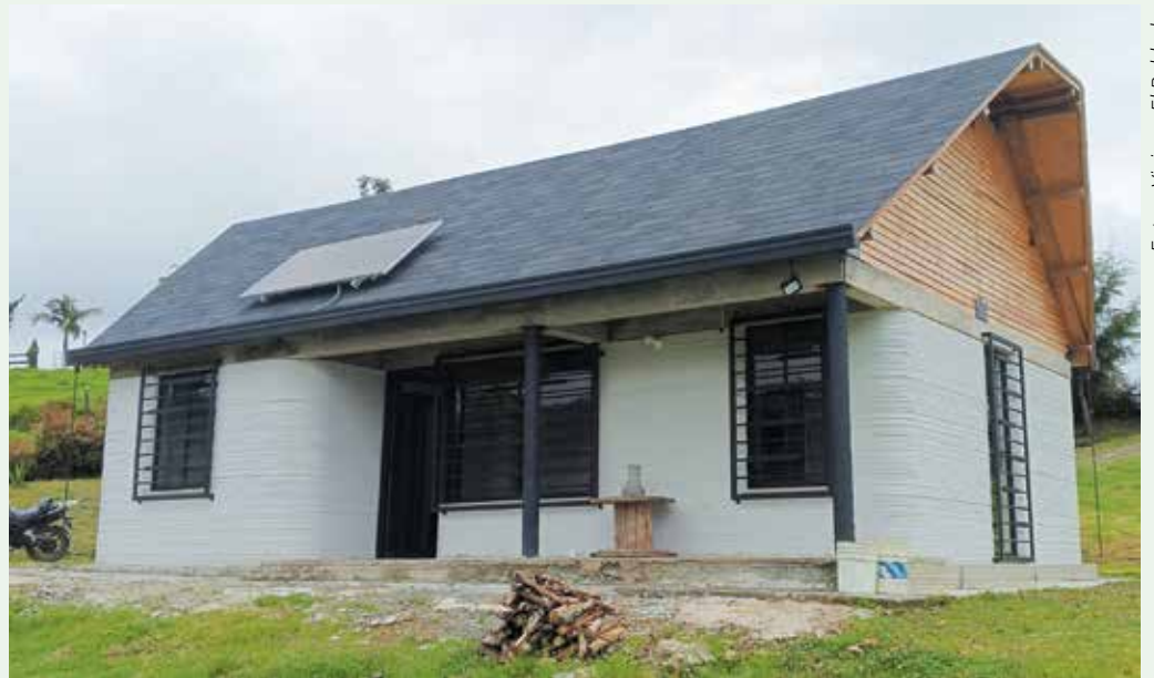
Esta es una de las dos primeras casas con muros levantados por impresoras 3D, en La Unión.
