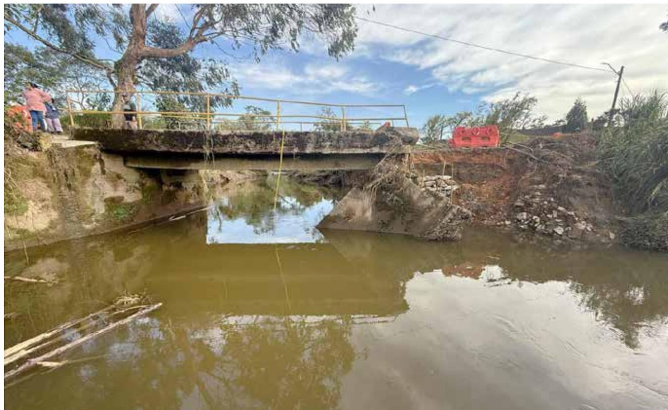
Así quedaron las bases del puente de la vía entre La Unión y El Carmen de Viboral, a la altura de la quebrada La Madera. La fuerza de las aguas se llevó parte de la banca de la estructura. El paso vehicular y peatonal por el lugar fue cerrado mientras se reparan los daños.
