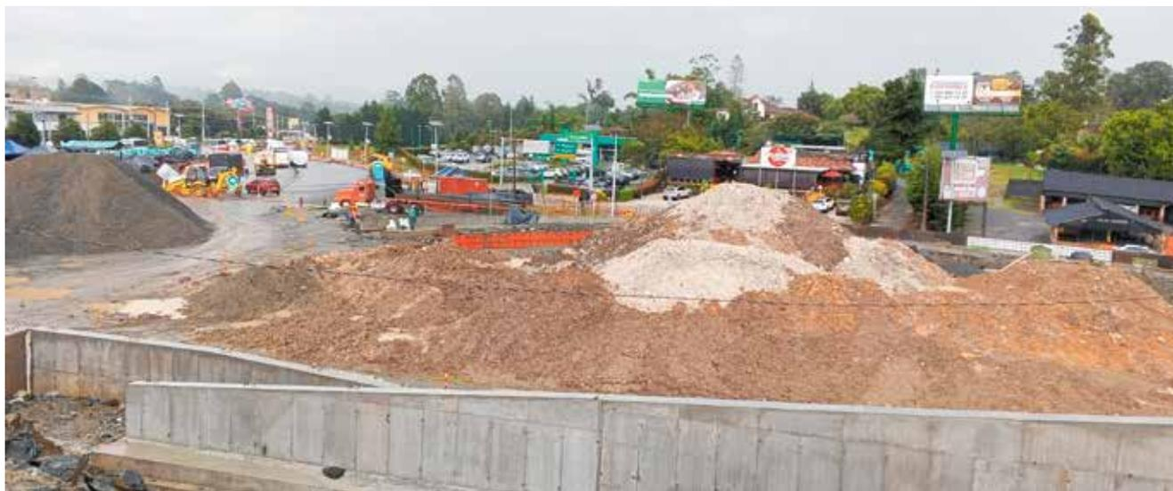
Para el material de refuerzo de los terraplenes del puente y de los futuros lazos internos del intercambio se han aprovechado más de 154 mil metros cúbicos de roca extraída durante la construcción del llamado túnel del Seminario, en el Túnel de Oriente.
