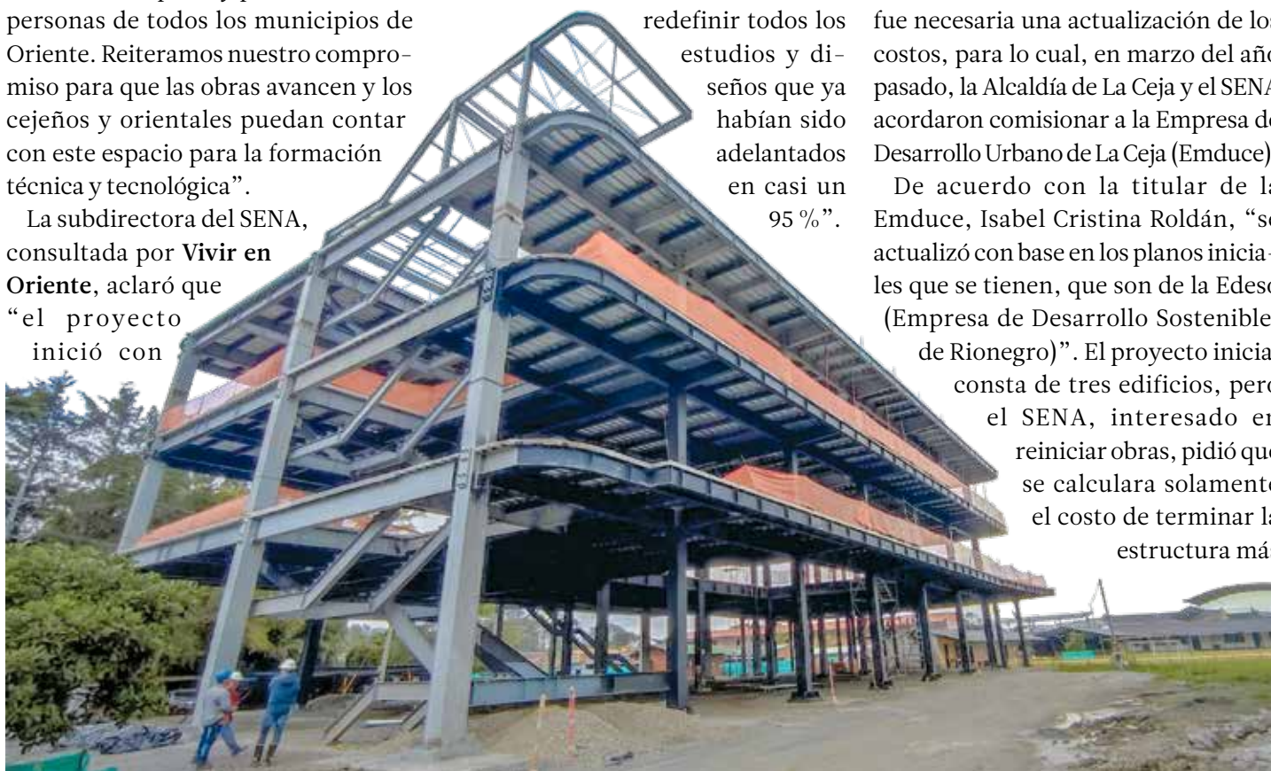
Con el envío al que se comprometió el SENA la semana pasada, se espera concluir las pocas tareas de la fase A del edificio (cimentaciones y estructura). Vendrían luego la fase B (redes secas y húmedas, mamposterías, acabados) y la fase C (urbanismo).
