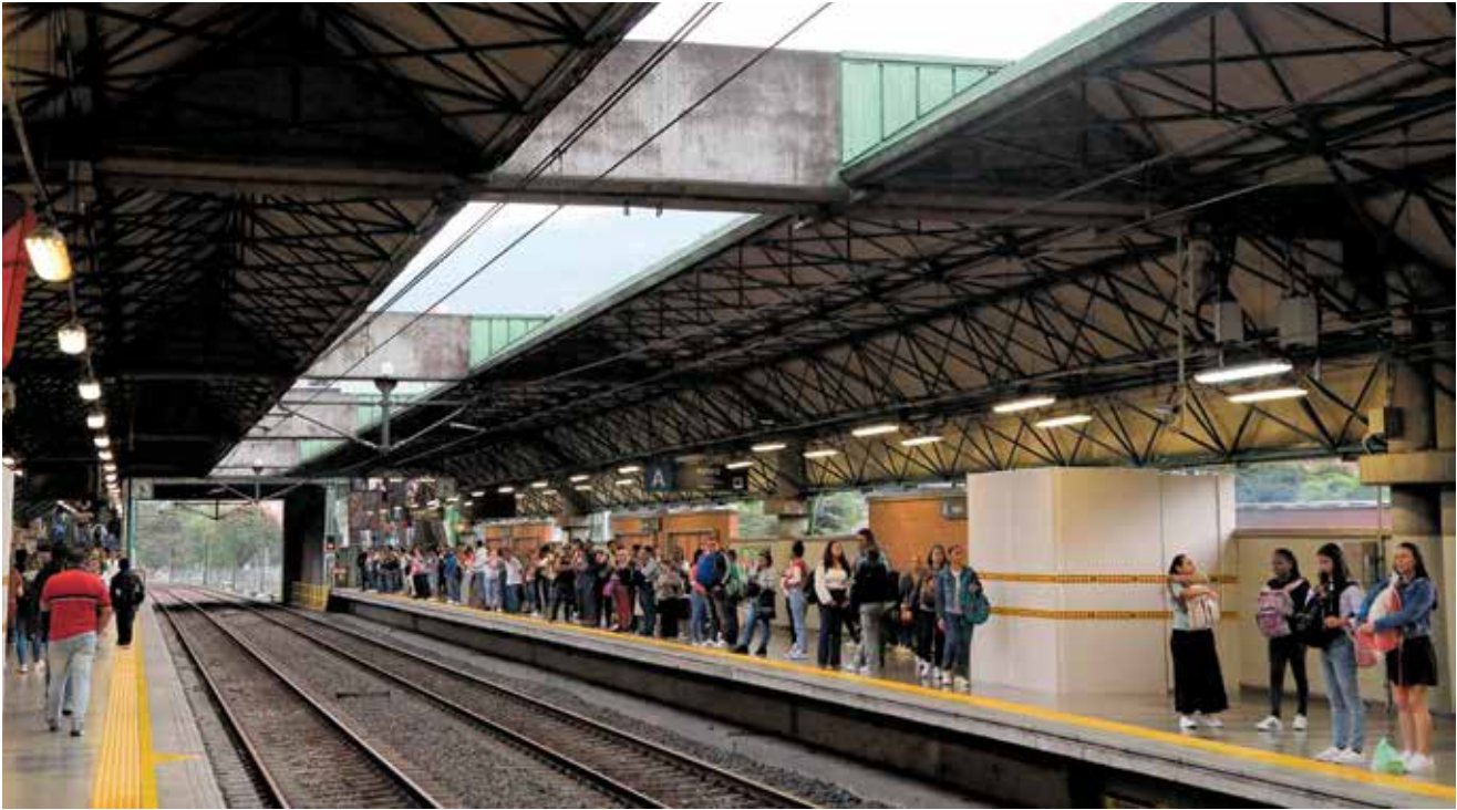
Aspecto actual de las plataformas de acceso a los vagones del Metro, en la estación Ayurá, con los espacios reservados para futuros ascensores. Las obras pueden generar cambios en la circulación dentro de la estación y la reducción de espacio en parte de las plataformas, sin embargo, no se afectará el servicio.
