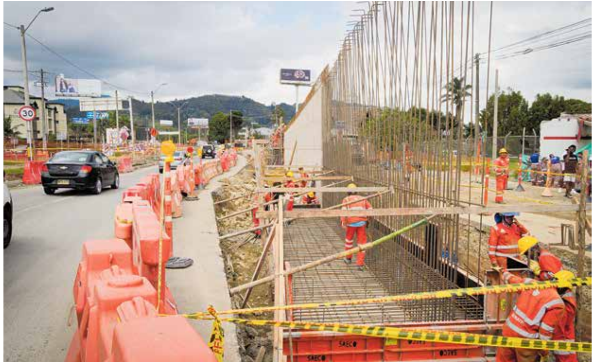
En breve comenzar  la construcci n de los terraplenes o rampas de acceso al puente del intercambio, cuya estructura principal ya est  terminada. Antes de acabar este mes, se citar  un nuevo comit  ciudadano de obra para evaluar el impacto de los trabajos y los desv os viales.
