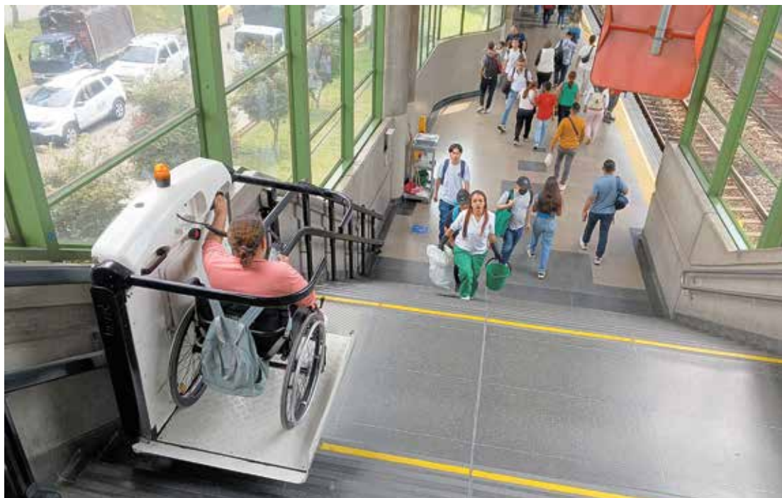
Pese a ser un valioso facilitador de la movilidad en la ciudad y en nuestra comuna, al sistema metro se le critica la presencia de aparatos como estas plataformas salvaguardas, para personas en sillas de ruedas. Son lentas, necesitan recarga de energía, se averían con relativa frecuencia y ofrecen una solución individual, dentro de un sistema masivo.
