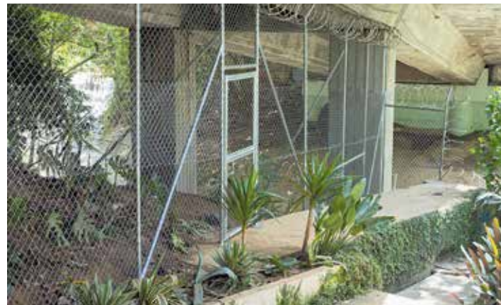
Con la reja de seguridad, instalada por las comunidades aledañas al viaducto, se busca erradicar los cambuches de los consumidores de drogas en los bajos del puente.
