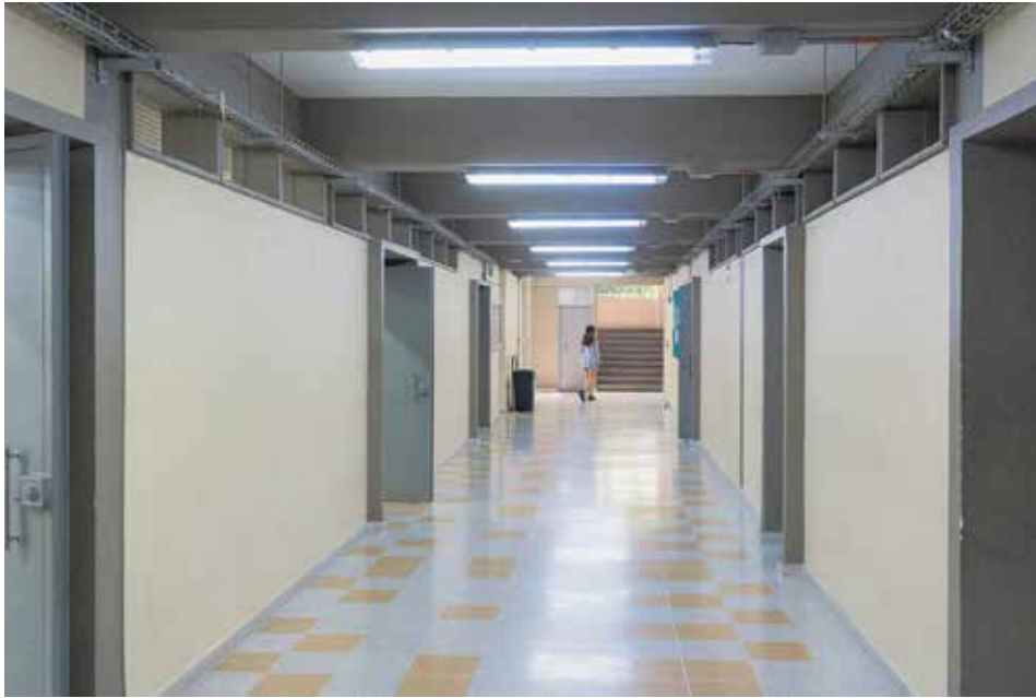
La remodelación y recuperación de tres bloques propicia mejores espacios para el modelo educativo en el INEM José Félix de Restrepo.
