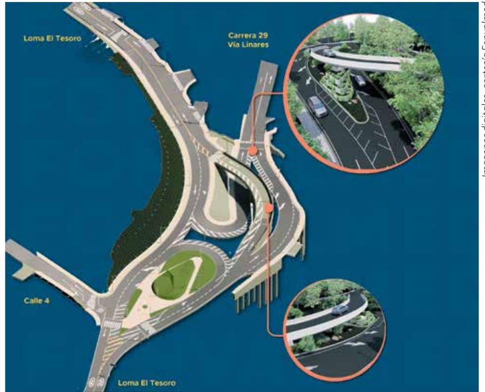
El intercambio de Linares constará de un paso a desnivel (puente) que le dará continuidad a la vía en la loma de El Tesoro, con posibilidades de giro seguro hacia la carrera 29 y la calle 4. Requerirá de muros de contención en su costado oriental.
