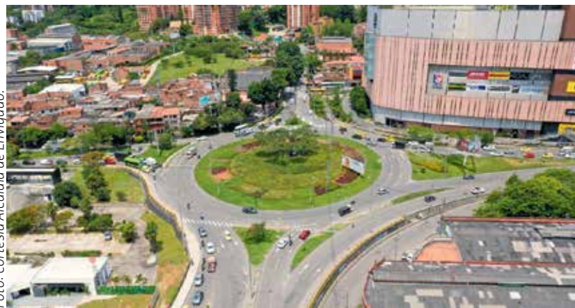
El de Mayorca, sobre la avenida Las Vegas, es uno de los tres intercambios viales proyectados por el Área Metropolitana en el municipio de Envigado.
