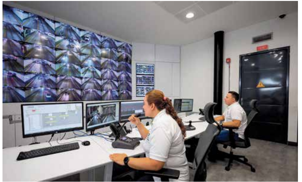
El Centro de Control de Operaciones de la Concesión Túnel Aburrá Oriente monitorea los datos suministrados por cinco mil aparatos, que alimentan 25 subsistemas, para garantizar el uso seguro de la vía.
