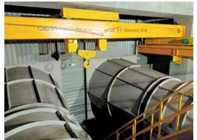
Dos pares de enormes ventiladores, ubicados en cada salida del túnel Santa Elena (un par en Sajonia y otro en el ingreso occidental), mantienen la buena calidad del aire dentro de la estructura.
