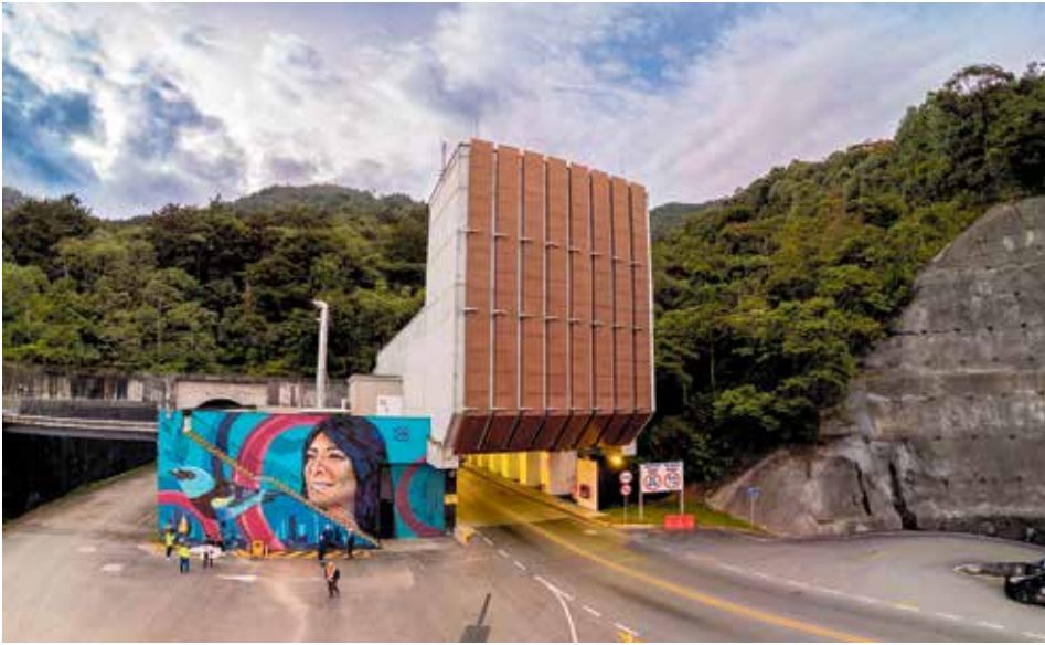
Ingreso occidental al túnel Santa Elena, el tercer túnel carretero más largo de América y el primero en uso bidireccional. Se pueden apreciar las ventanas de salida que hacen parte de un sofisticado sistema de ventilación.
