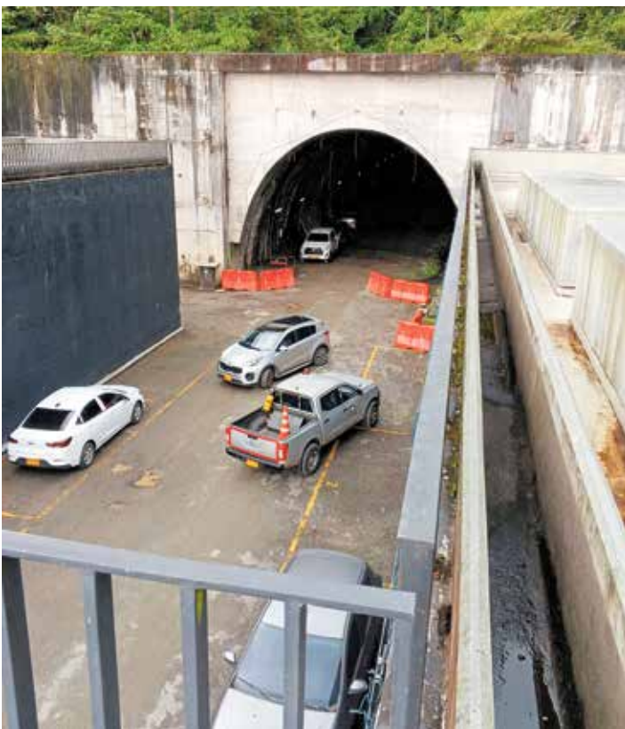
El cale del segundo túnel de Oriente está listo; faltan tres años de obras complementarias, para lo cual se necesitan dos billones de pesos y un nuevo contrato que está preparando la Gobernación de Antioquia.
