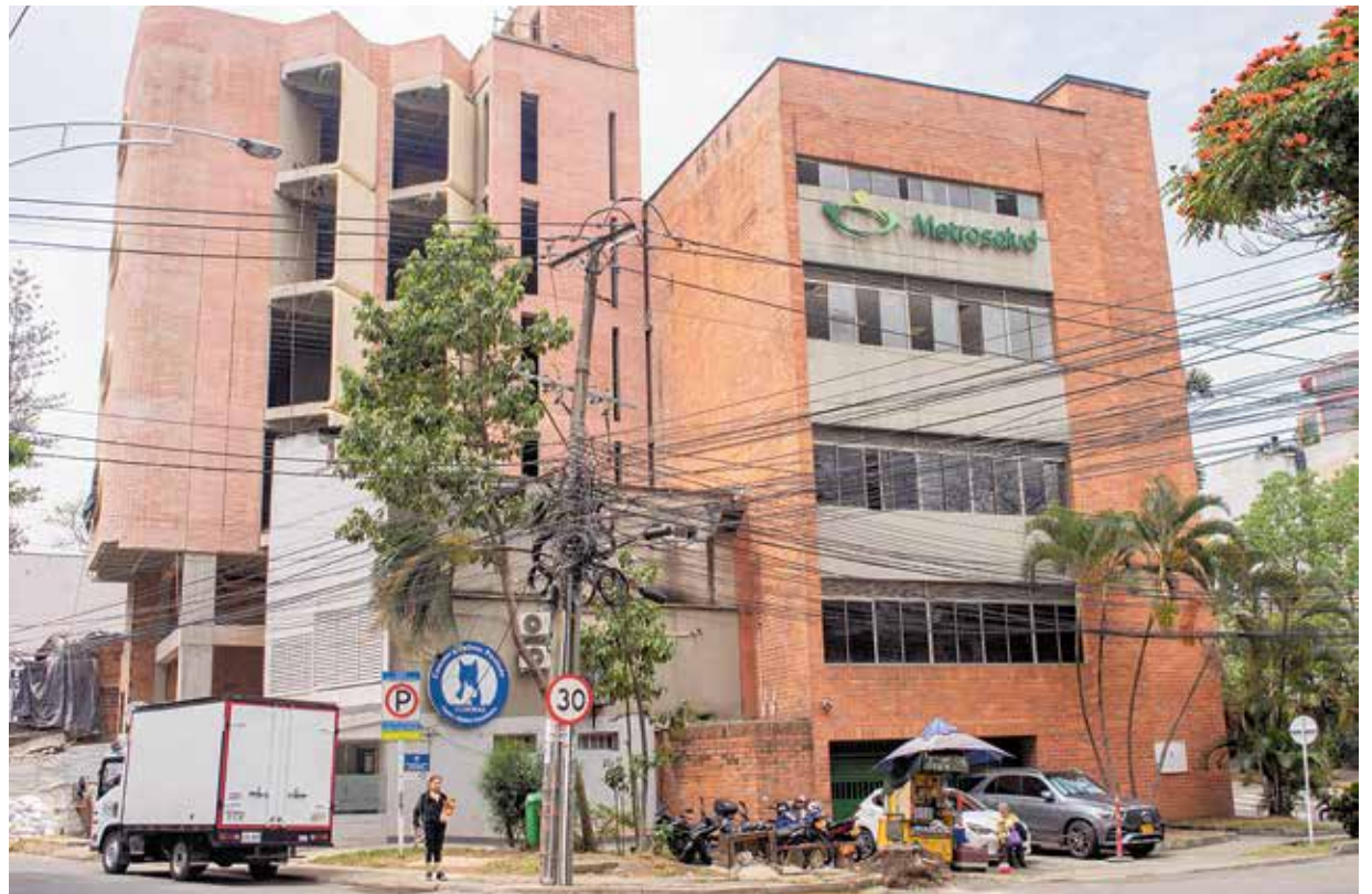
Los trabajos de remodelación en la sede de Metrosalud, en El Poblado, se efectuaron, a lo largo de cuatro meses, sin necesidad de parar la atención a los usuarios de dicha ESE distrital en la Comuna 14.
