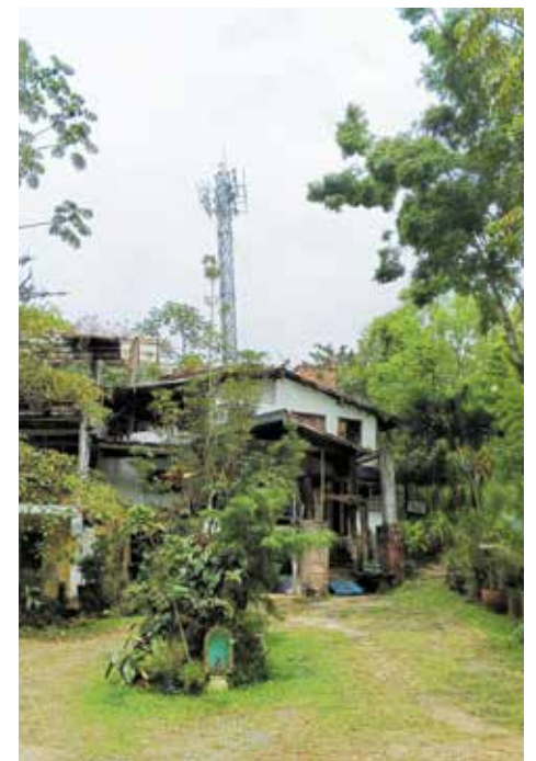
Esta antena de telecomunicaciones, ubicada en el vecino sector de La Palmera, ya perdió su verticalidad por la inestabilidad del terreno.
