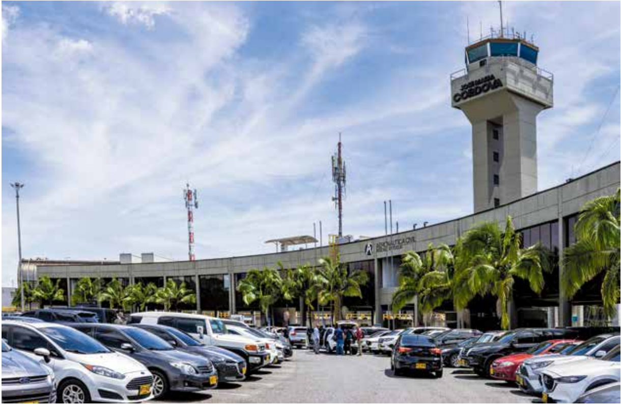
El aeropuerto se acoge a la ley 1618 del 2013 que garantiza los derechos de las personas en situación de discapacidad. Capacitaciones al personal, cambio de estructuras y asignación de celdas de estacionamiento son algunas de las acciones que se han hecho para lograrlo.
