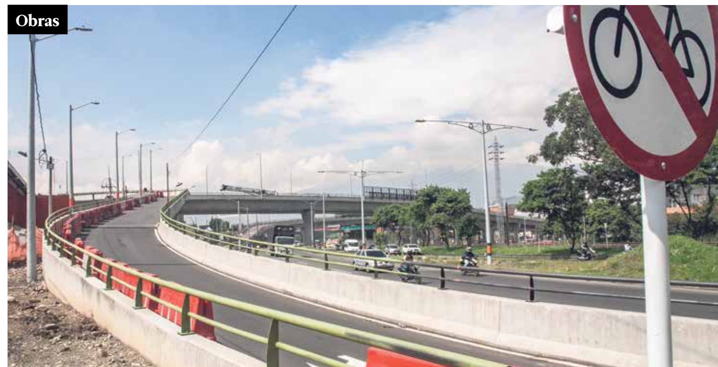
Están casi listos los 17 ejes viales del intercambio, con sus 6.2 kilómetros distribuidos en 5 puentes, dotados de capa asfáltica y señalización.
