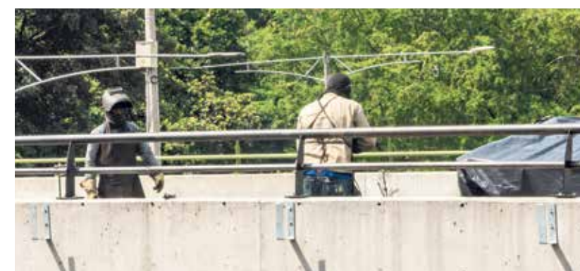
Mientras se entrega la obra, ya está habilitado para el servicio vehicular un tramo en Envigado que, en sentido oriente-occidente, conecta el corredor de La Ayurá con la Regional.
